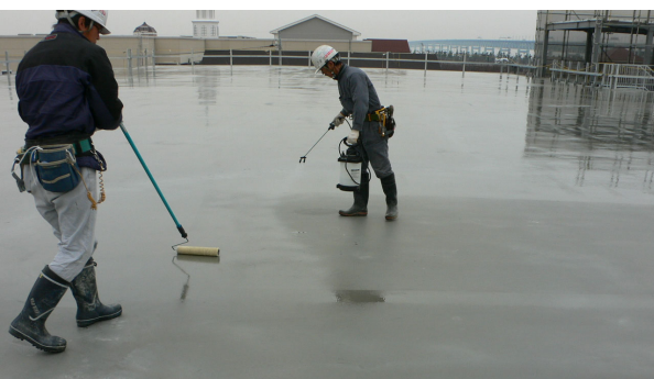
CS-21 塗布状況
