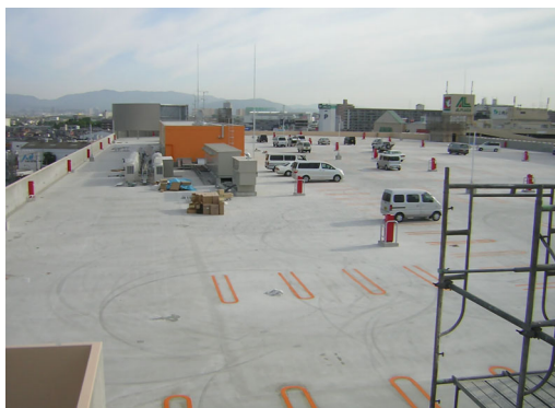
屋上駐車場全景
