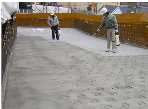
スロープ：CS-21散布状況
