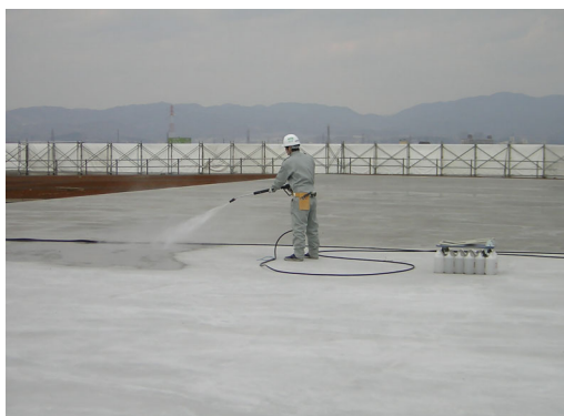
散水養生状況
