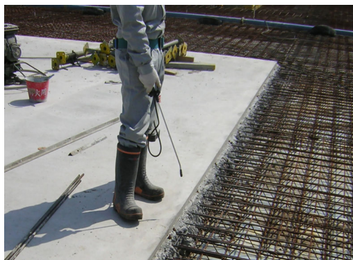
打継ぎ部：CS-21散布状況
