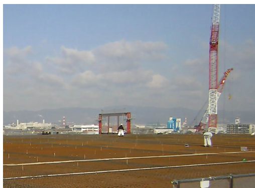
鉄筋検査状況
