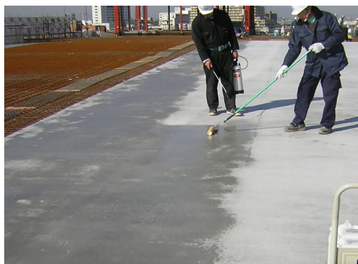
CS-21塗布状況
