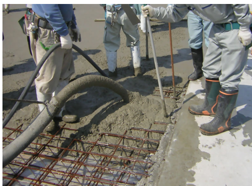
コンクリート打設立会い状況
