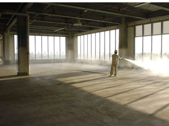
散水養生状況
