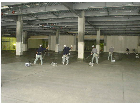
CS-21 塗布状況
