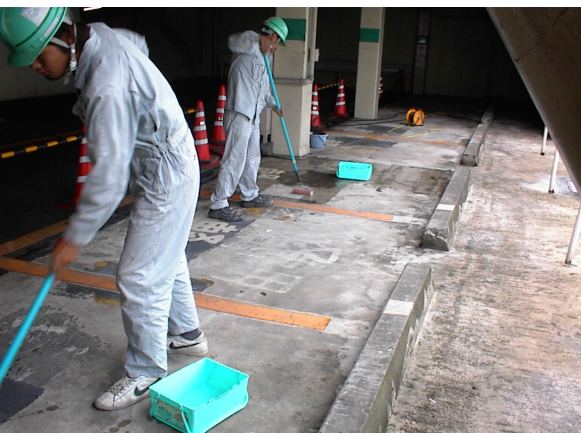
CS-21 塗布状況
