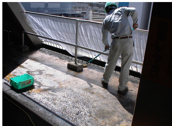
CS-21 塗布状況
