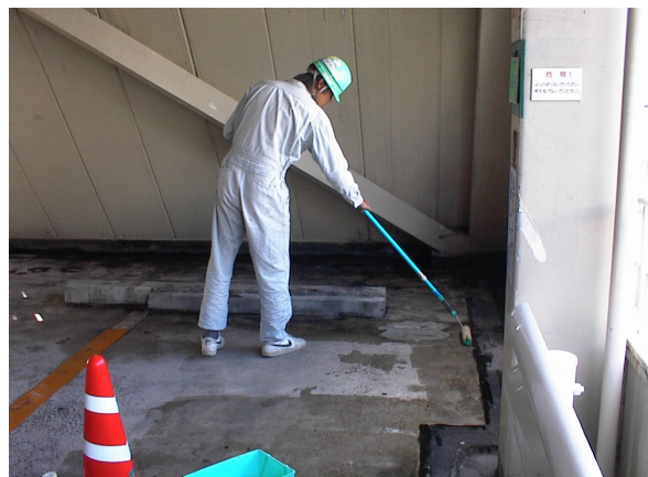
CS-21 塗布状況
