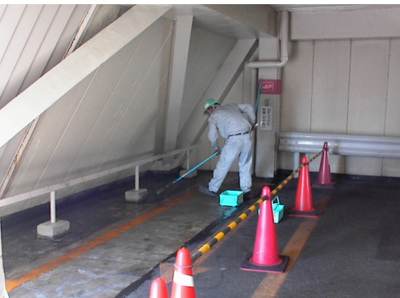
CS-21 塗布状況
