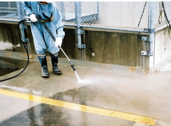
高圧洗浄状況
