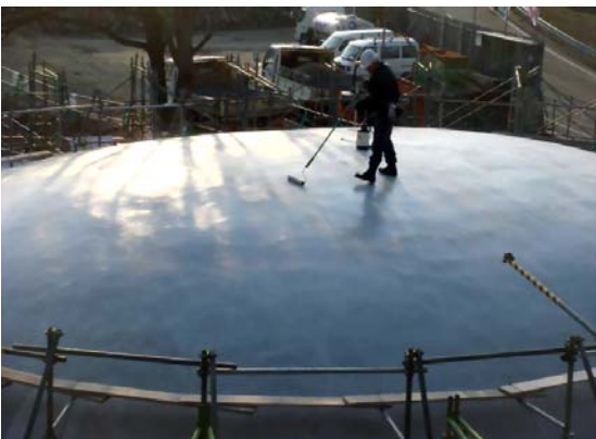
CS-21 塗布状況
