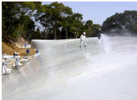
散水養生状況
