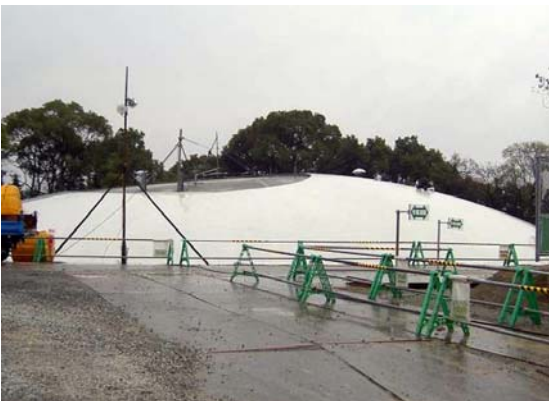
施工箇所全景
