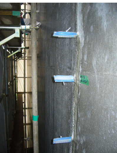
CS-21 注入状況
