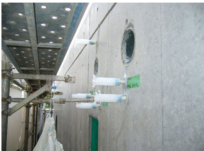
CS-21 注入状況
