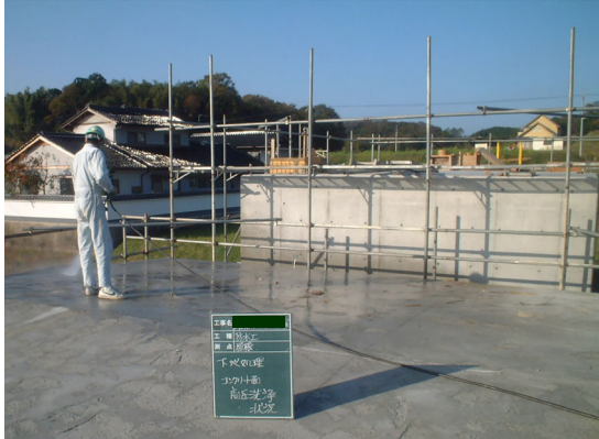
屋根：下地処理（高圧洗浄）状況
