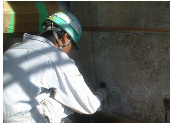
地中壁：木コン部処理状況
