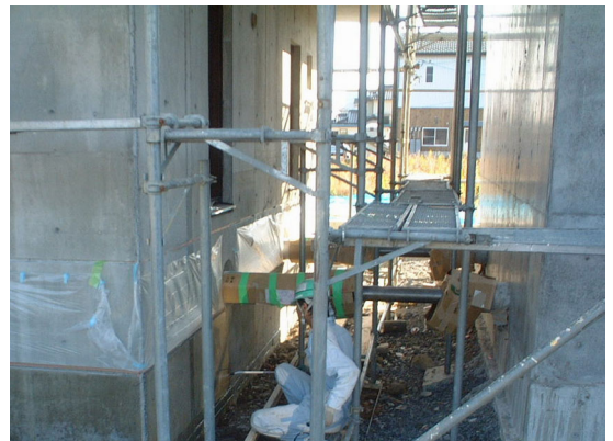
地中壁：CS-21散布状況
