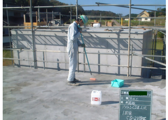
屋根：CS-21塗布状況
