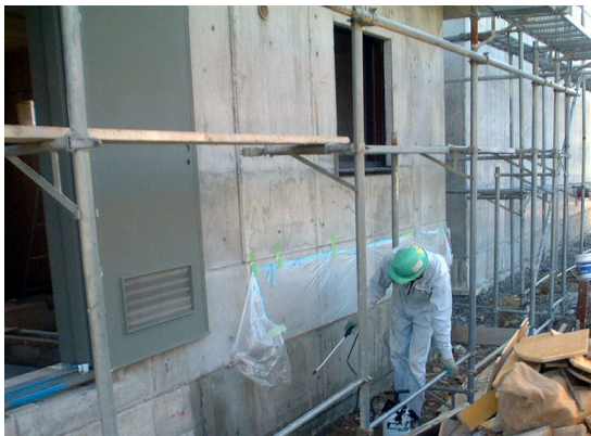
地中壁：CS-21散布状況
