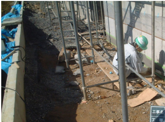
地中壁：打継ぎ目処理状況
