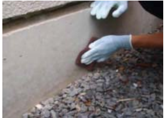
下地処理（清掃）状況
