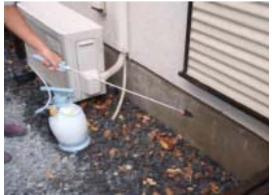
散水養生状況
