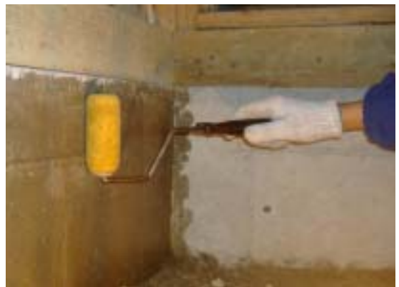
CS-21 塗布状況（内面）
