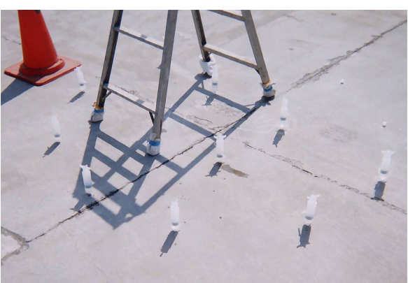
CS-21 低圧注入状況
