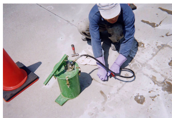
CS-21 注入状況 (ケミカルポンプ)
