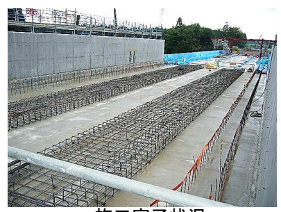
施工完了状況
