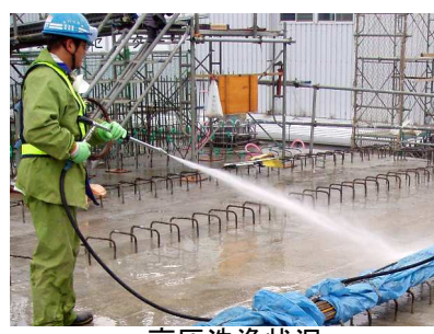
高圧洗浄状況
