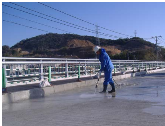
高圧洗浄状況
