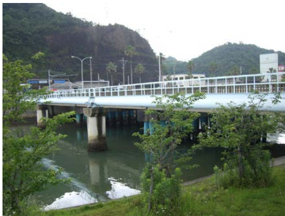
施工箇所全景
