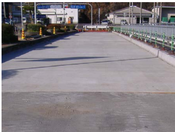
舗装撤去状況
