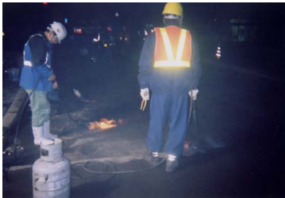
CS-21 施工前：強制乾燥
