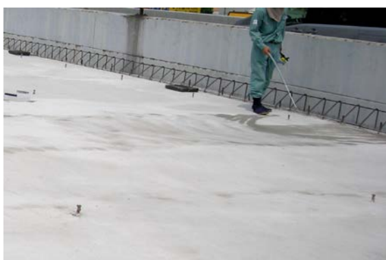
湿潤散水状況
