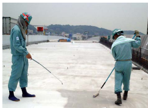
CS-21 塗布状況
