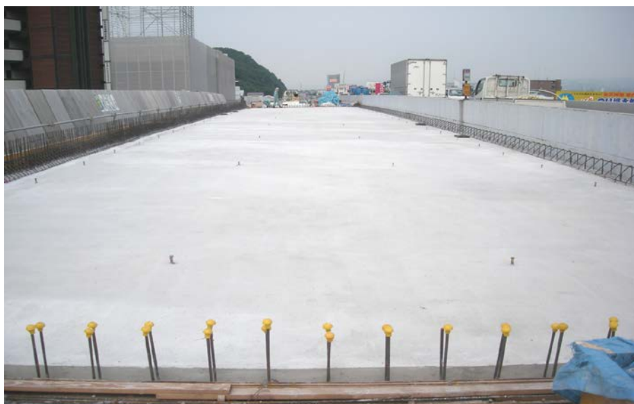
施工箇所全景
