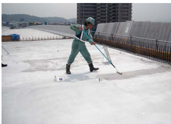
CS-21 塗布状況
