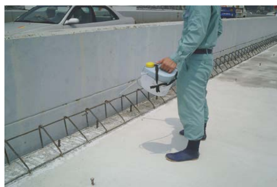
打継ぎ部CS-21 散布状況
