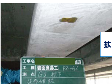
塗布確認シート（施工後）
