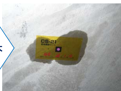
塗布確認シート（施工後）
