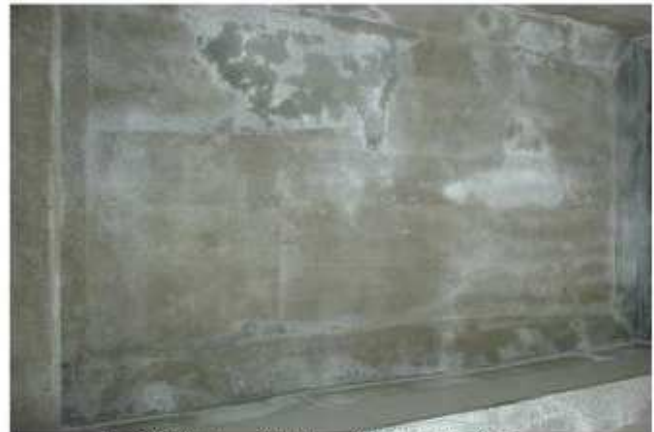
下面拡大：漏水・浮き共になし
