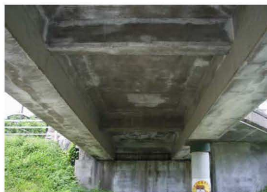
下面拡大：漏水・浮き共になし
