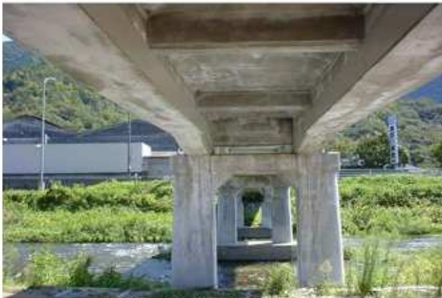
下面：漏水・浮き共になし
