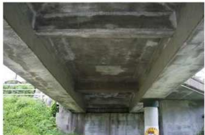
下面拡大：漏水・浮き共になし
