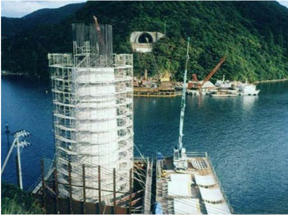
施工箇所全景
