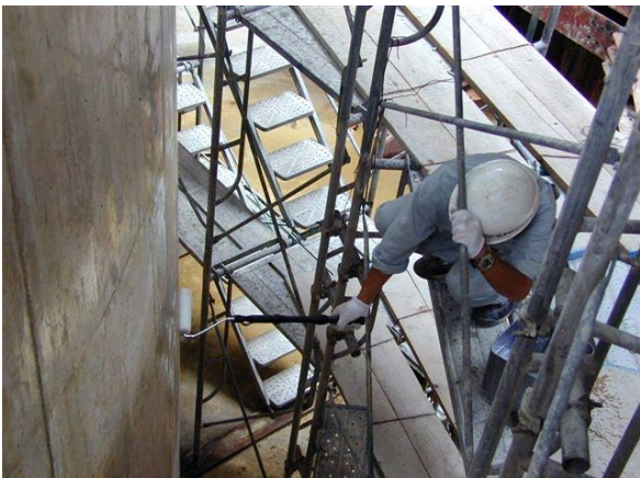
CS-21 塗布状況
