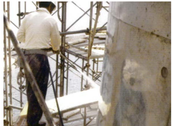
湿潤散水状況
