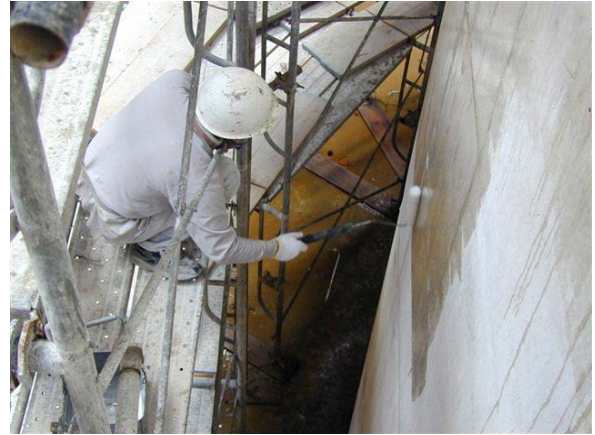
CS-21 塗布状況
