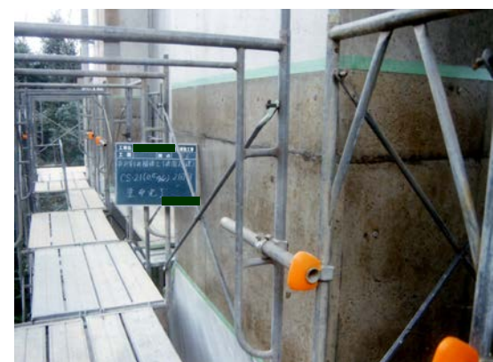
CS-21塗布(2回目)完了状況
