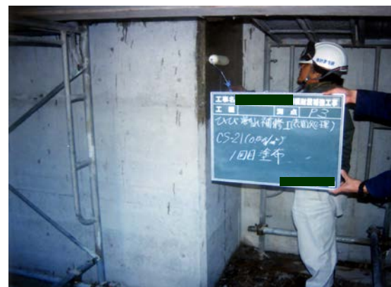
CS-21塗布(1回目)状況
