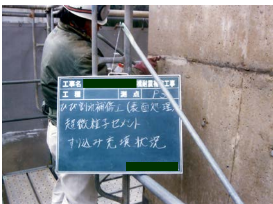
微粒子セメントすり込み状況
