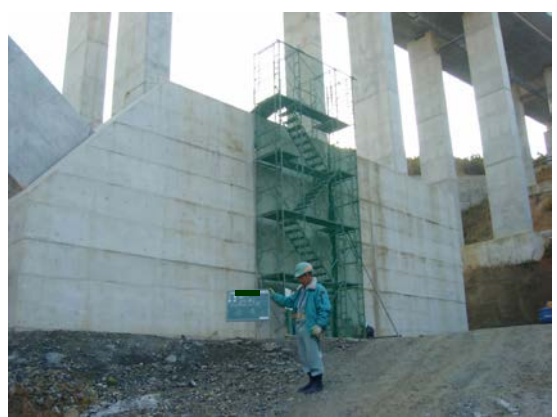
施工箇所全景
