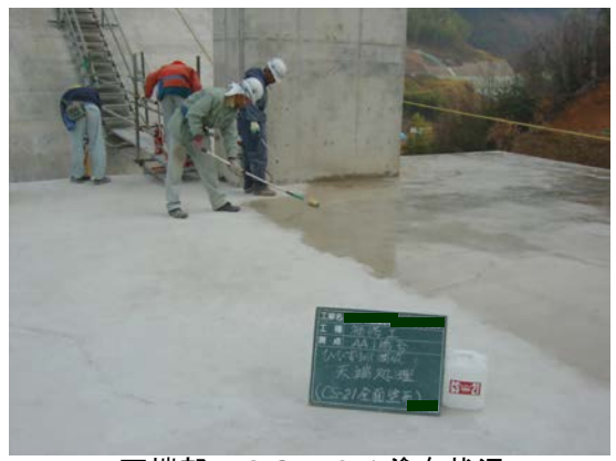
天端部：CS-21塗布状況
