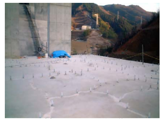
天端部：CS-21注入状況
