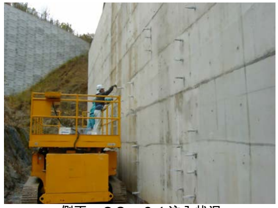
側面：CS-21注入状況
