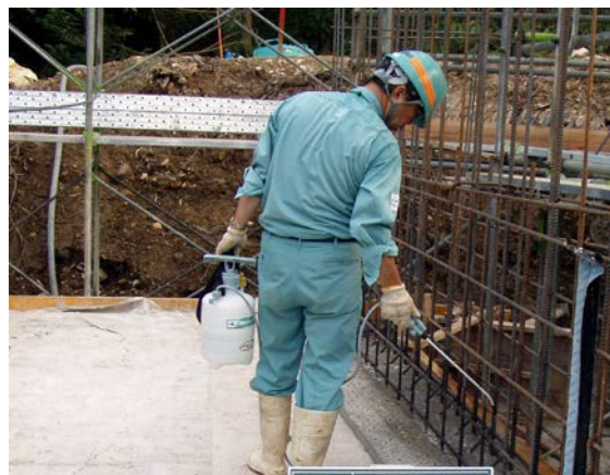
打継ぎ部：CS-21 散布状況
