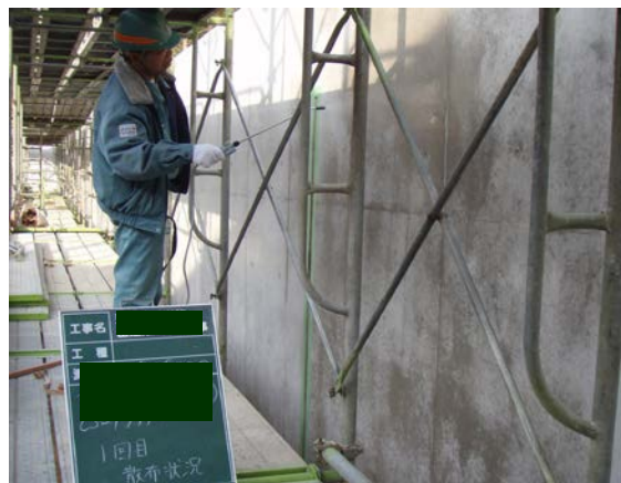
側壁：CS-21 散布状況
