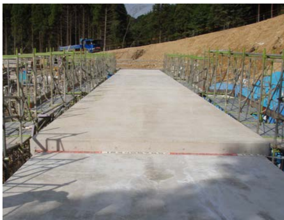
施工箇所全景
