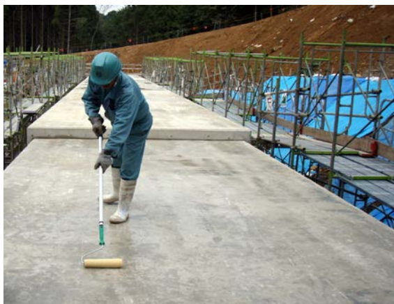
頂版：CS-21 塗布状況
