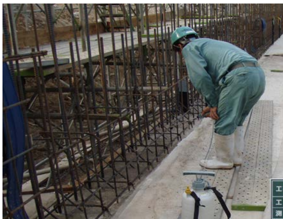
打継ぎ部：CS-21 散布状況
