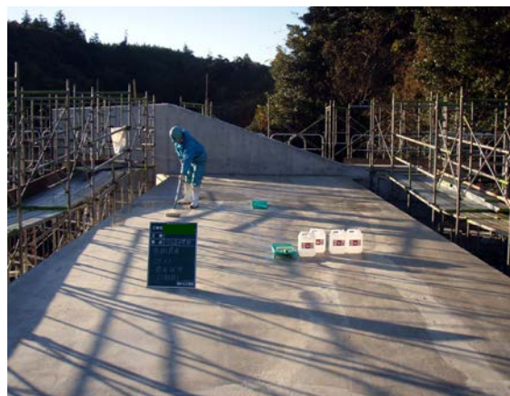
頂版：CS-21 塗布状況
