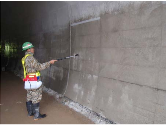
湿潤散水状況
