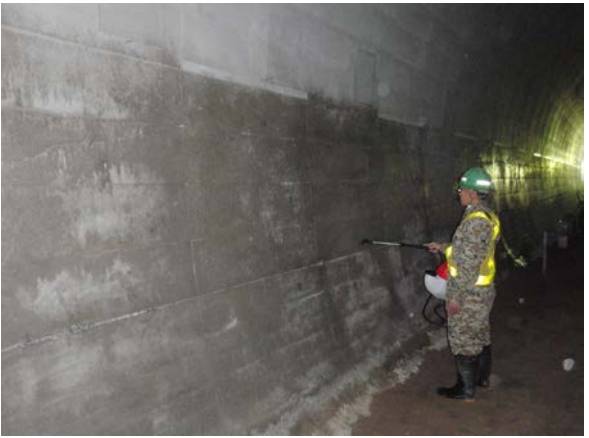
湿潤散水状況
