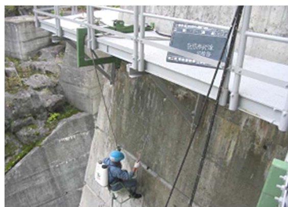
CS-21 散布状況
