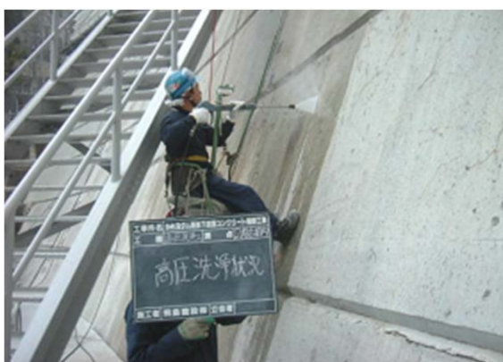
高圧洗浄状況
