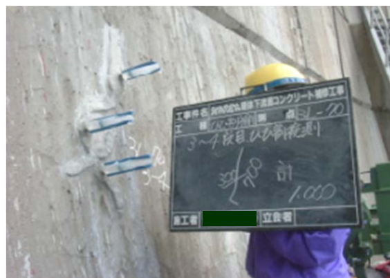
ひび割れ低圧注入状況
