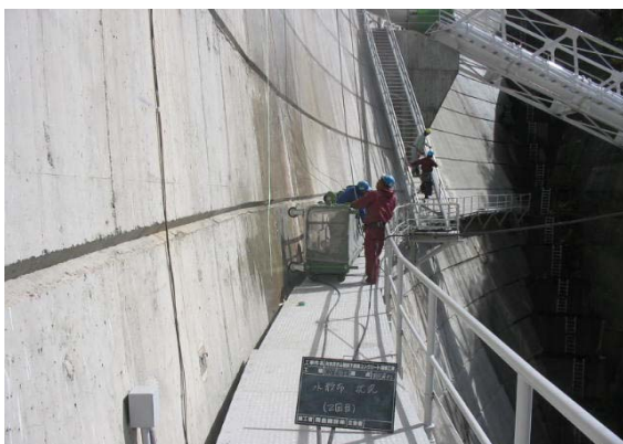
湿潤散水状況
