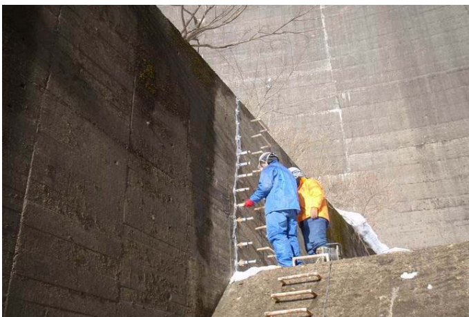
減勢工（ひび割れ低圧注入状況）
