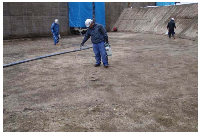
減勢工（CS-21 散布状況）
