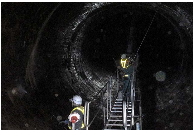
洪水吐トンネル（CS-21 散布状況）
