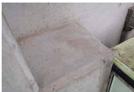
断面修復箇所
