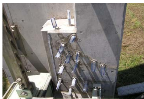
ひび割れ注入状況
