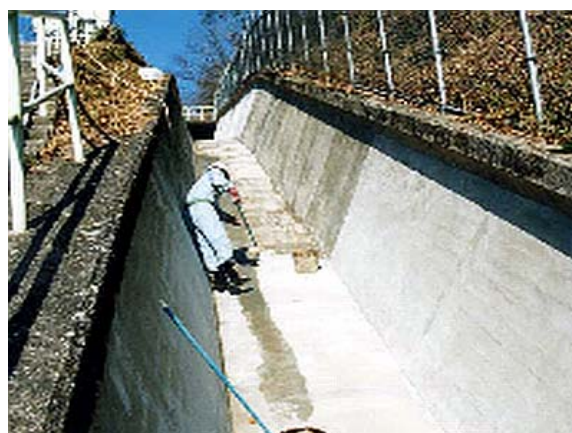
CS-21塗布状況
