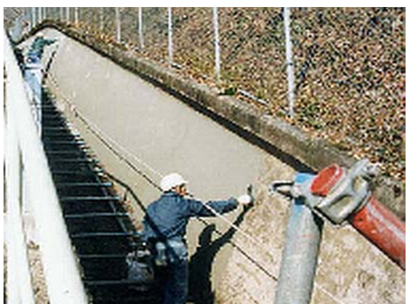
ポリマーモルタルコテ塗り状況
