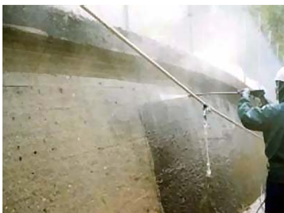
高圧洗浄状況
