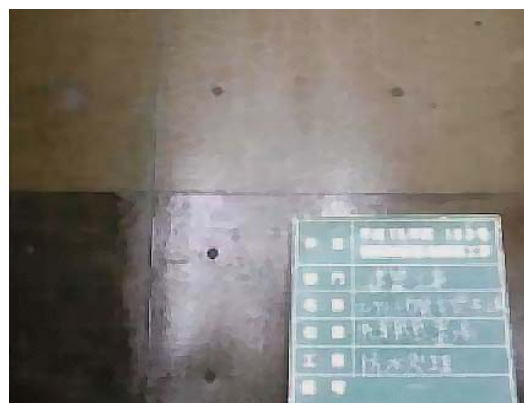
地下水槽外壁：施工完了
