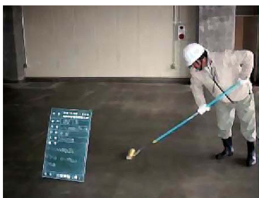
倉庫内床面：CS-21塗布状況
