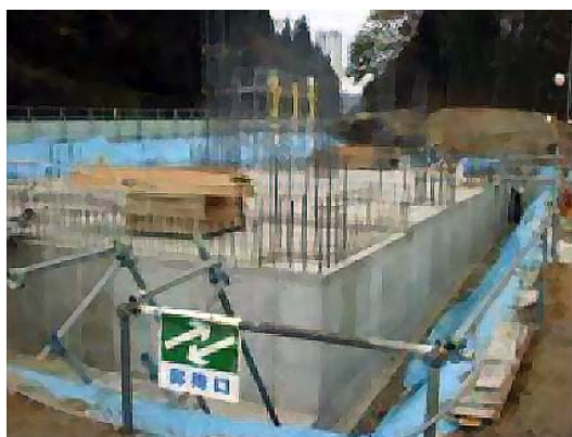
地下水槽全景
