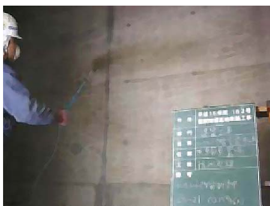
地下水槽外壁：CS-21散布状況
