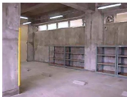
倉庫内床面：施工完了
