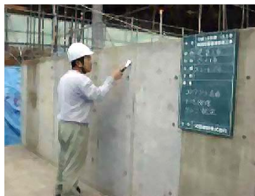
地下水槽外壁ケレン状況
