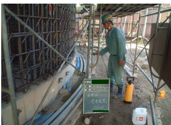
打継ぎ部：CS-21散布状況
