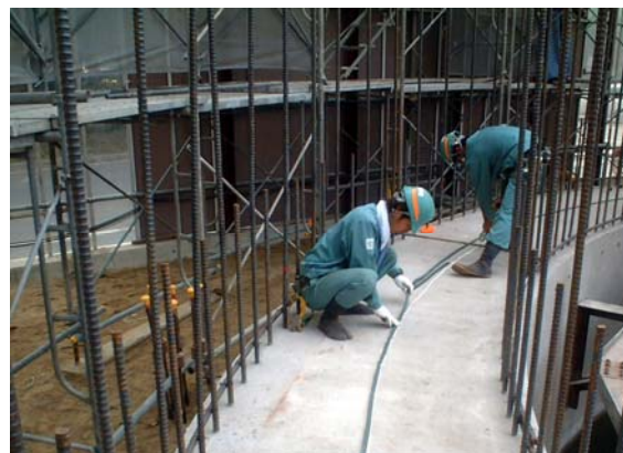
止水シール設置状況
