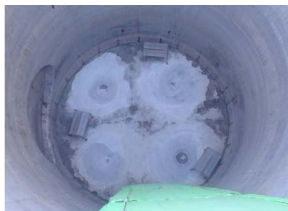
圧入後坑内状況
