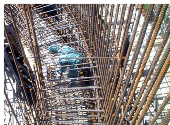
打継ぎ部：CS-21散布状況
