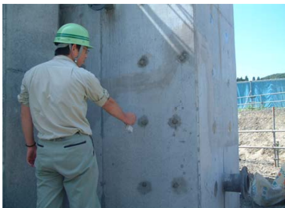
木コン処理：CS-21 散布状況
