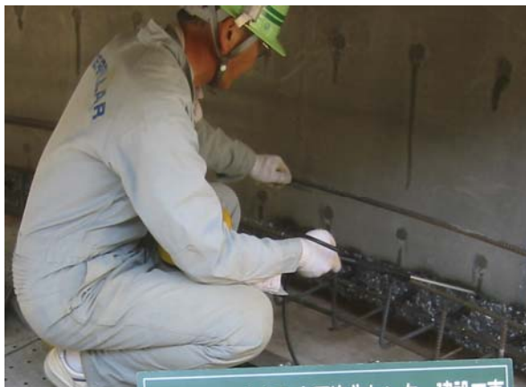
越流堰打継ぎ部：CS-21 散布状況
