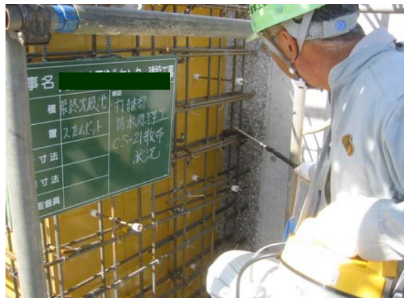
スカムピット打継ぎ部：CS-21 散布状況
