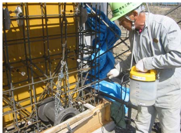
流出ピット配管部：CS-21 散布状況
