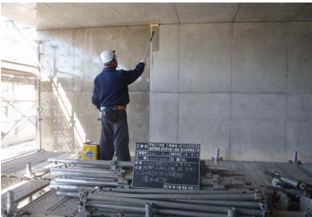
CS-21 塗布状況
