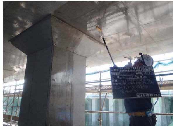
CS-21 塗布状況
