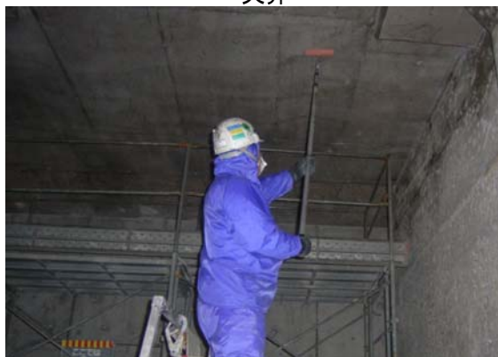
CS-21 塗布状況
