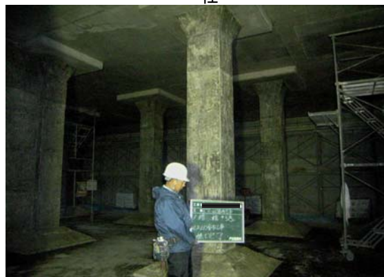
施工完了状況
