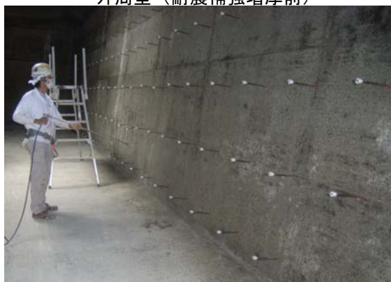
CS-21 散布状況
