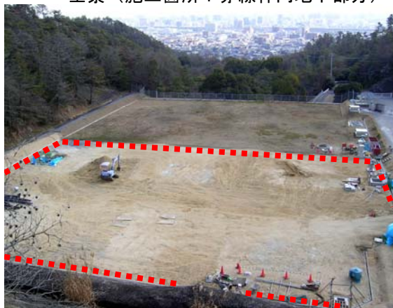
全景（施工箇所：赤線枠内地下部分）
