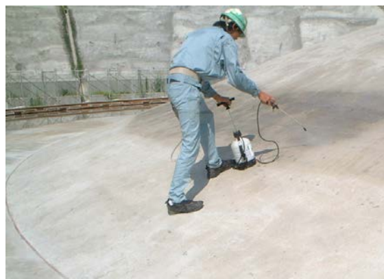
湿潤散水状況
