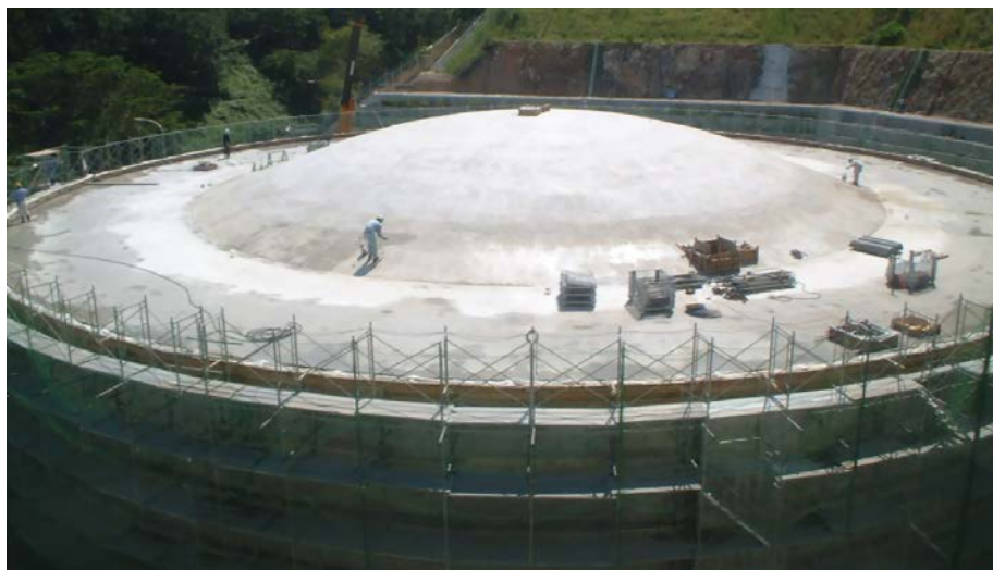
施工箇所 全景
