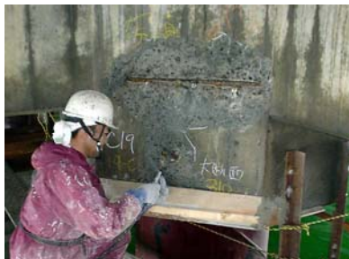
杭頭下面グラウト状況
