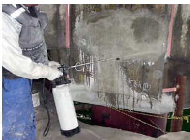
CS-21 散布状況
