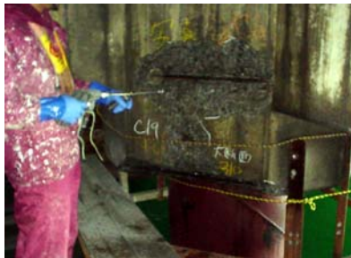
高圧洗浄状況
