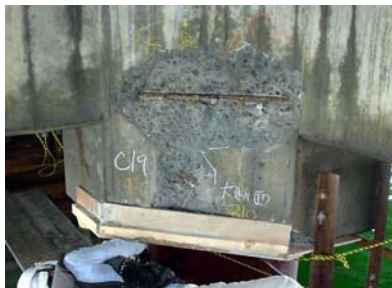
型枠設置状況
