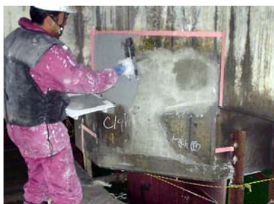
モルタル薄塗り状況
