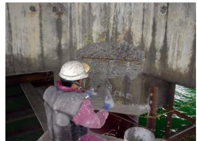
断面修復状況
