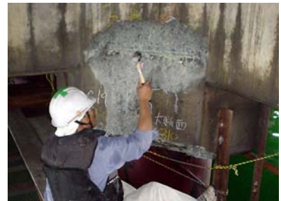
アンカー取付状況
