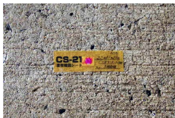
施工後：CS-21 塗布確認シート取付状況
