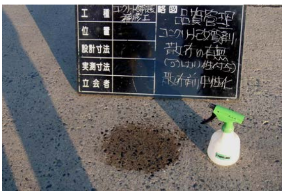
施工前：フェノールフタレイン1%溶液噴霧状況
