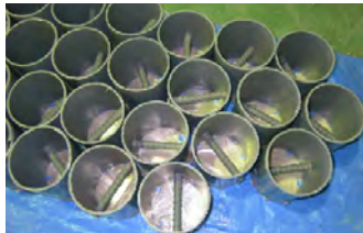
鉄筋配置状況
