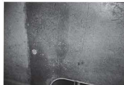
CS-21塗布後（正面右側4分の3）
