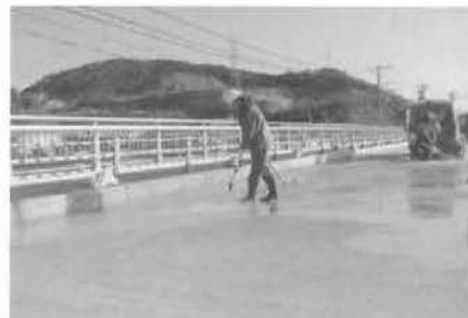
高圧洗浄状況
