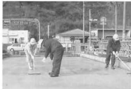
CS-21塗布状況
