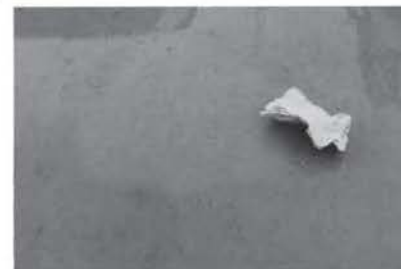
ひび割れ自閉効果の例（表面の汚れを拭き取ると、ひび割れが閉塞している状態が確認できる）
