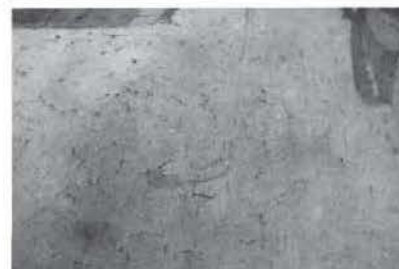
ひび割れ自閉効果の例（表面の汚れを拭き取ると、ひび割れが閉塞している状態が確認できる）
