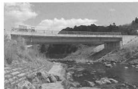
写真-3 施工箇所全景（追跡調査時・施工後5年半経過）
