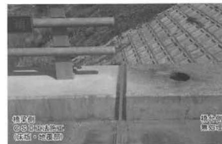
写真-4 地覆部(左)施工、(右)未施工(追跡調査時・施工後5年半経過)
