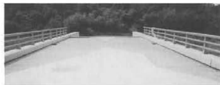
写真-2 施工完了
