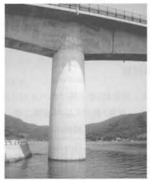
写真-5 施工箇所全景(追跡調査時・施工後約7年経過)
