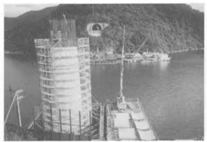
写真-1 施工箇所全景
