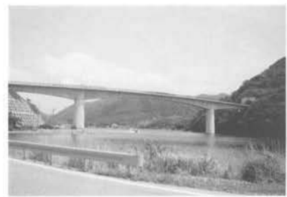
写真-4 橋梁全景(追跡調査時・施工後約7年経過)
