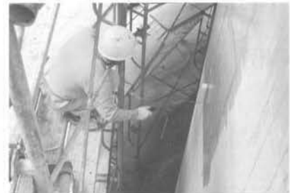
写真-2 表面含浸材塗布状況
