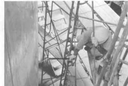
写真-3 表面含浸材塗布状況
