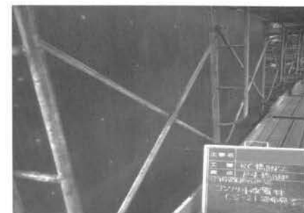
写真-3 施工完了
