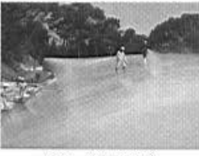
写真4 防水材施工状況
