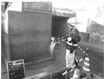
写真-1 高圧洗浄状況
