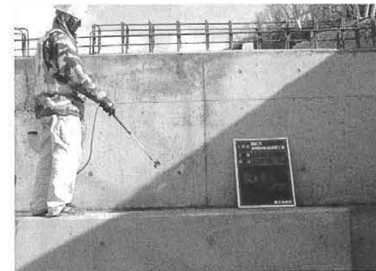
写真-3 散水養生状況
