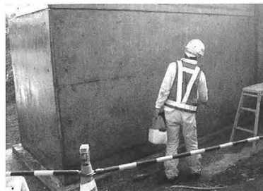
写真-2 施工状況
