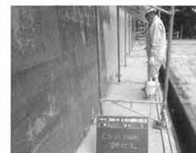
写真-3 表面含浸材塗布：1回目(躯体面)
