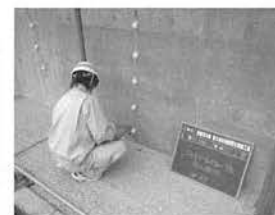
写真-2 ひび割れ注入(バルーン式)
