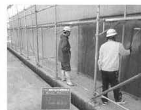
写真-5 表面含浸材塗布：2回目(被覆面)
