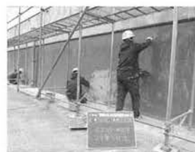
写真-4 表面被覆材こて塗り
