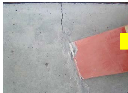
CSパテすり込み状況
