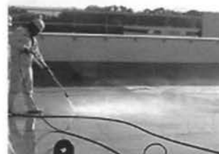
写真2 下地処理（高圧洗浄）
