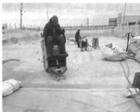
写真1 既存塗膜撤去
