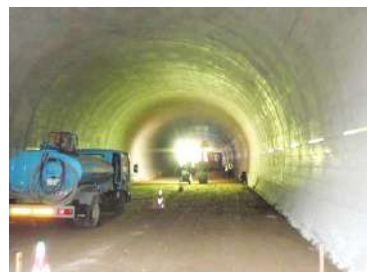
トンネル覆工部 表面保護
