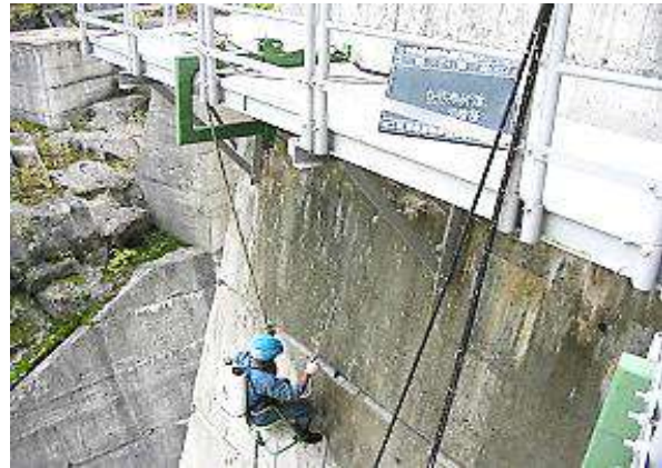
ダム堤体下流面：CS-21 散布状況
