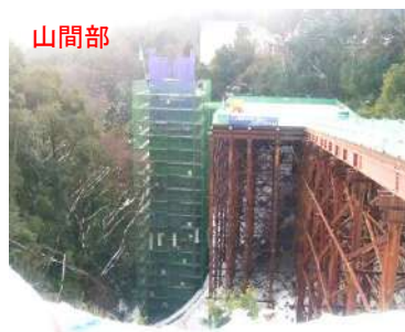
山間部 新設橋脚の凍害・中性化対策
