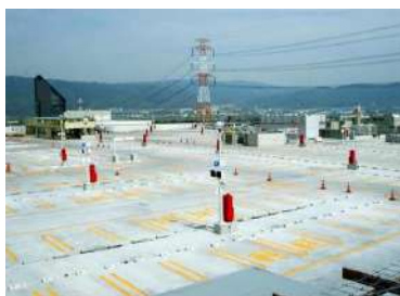
屋上駐車場防水
