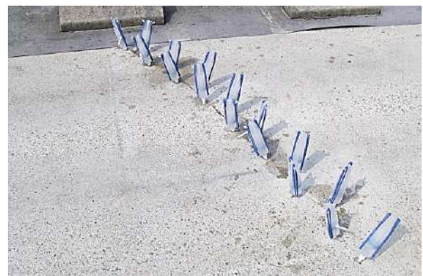
漏水補修（低圧注入）状況：駐車場
