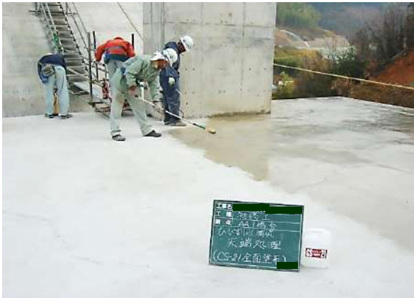
橋台上部：CS-21 塗布状況
