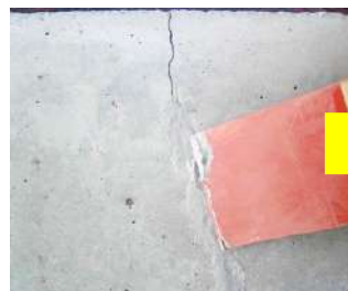
CSパテすり込み状況
