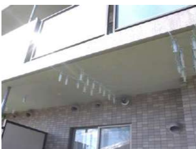
ひび割れ補修：ベランダ
