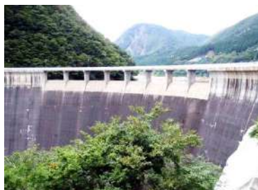
ダム（堤頂・越流部）表面保護
