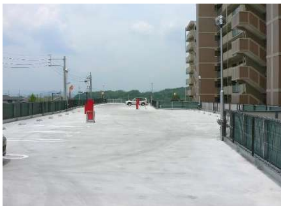
立体駐車場防水
