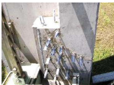
ひび割れ低圧注入
