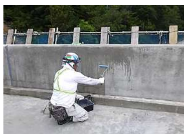
横向き塗布 (壁高欄)
