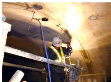
ひび割れ高圧注入
