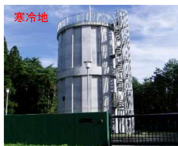
寒冷地 既設配水塔の長寿命化対策
