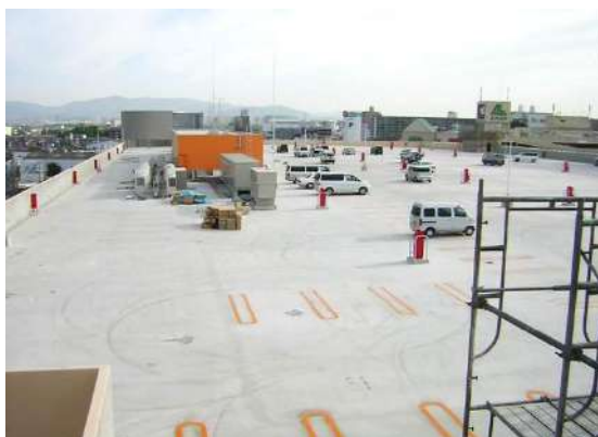
屋上駐車場防水
