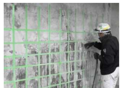
漏水補修：地下室
