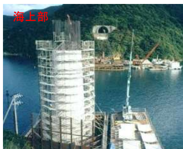
海上部 新設橋脚の塩害対策
