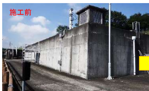
既設浄水池（水道施設）外壁の長寿命化＋美観回復対策
