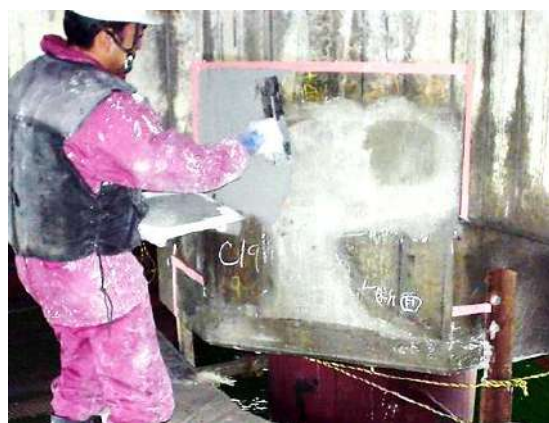
断面修復状況
