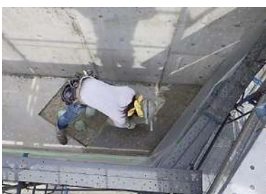
下向き塗布 (橋座部)
