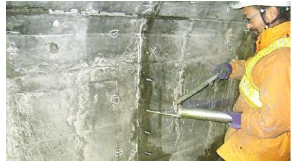
漏水補修（高圧注入）状況：水路トンネル
