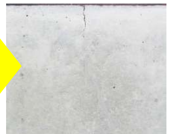
施工完了 (上端部一部未補修)
