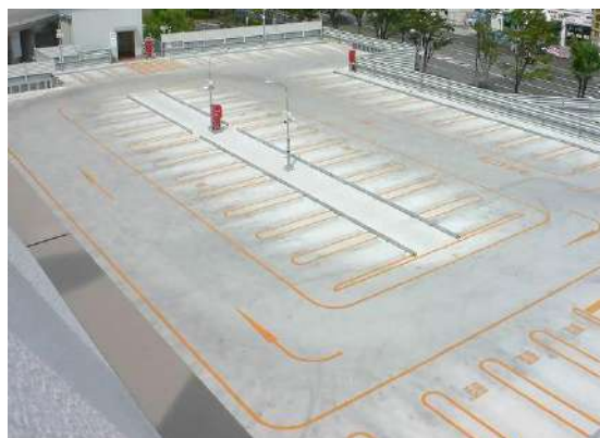
立体駐車場防水
