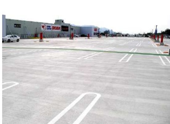
屋上駐車場防水
