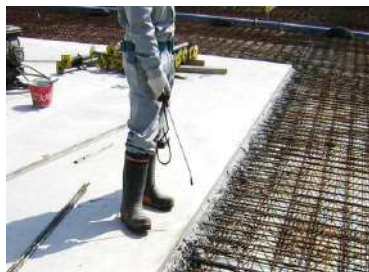
打継ぎ部処理（鉛直打継ぎ部）
