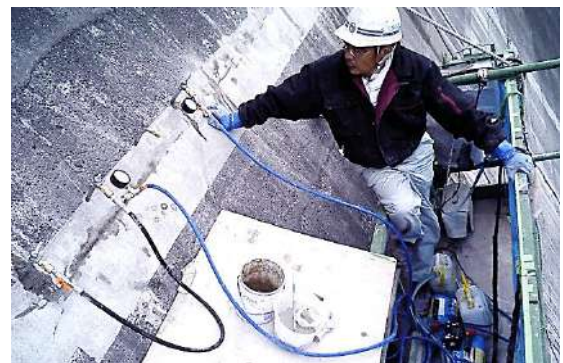
漏水補修（高圧注入）状況：ダム
