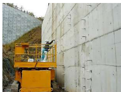
ひび割れ補修：橋台
