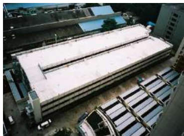
立体駐車場防水
